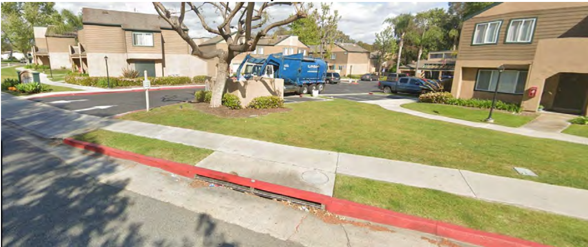
196 Via Lomas 215' E/O Moulton Pkwy N/S
