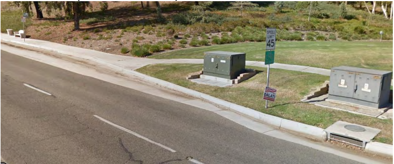
183 Moulton Pkwy 10' N/O Oso Pkwy E/S
